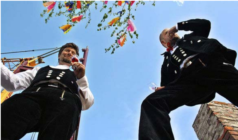
Zimmermeister Martin Bär (rechts) und sein Kollege Markus Schur bei ihrem Richtspruch auf dem Dach des Farrenstalls. Foto: Richard Dressler
